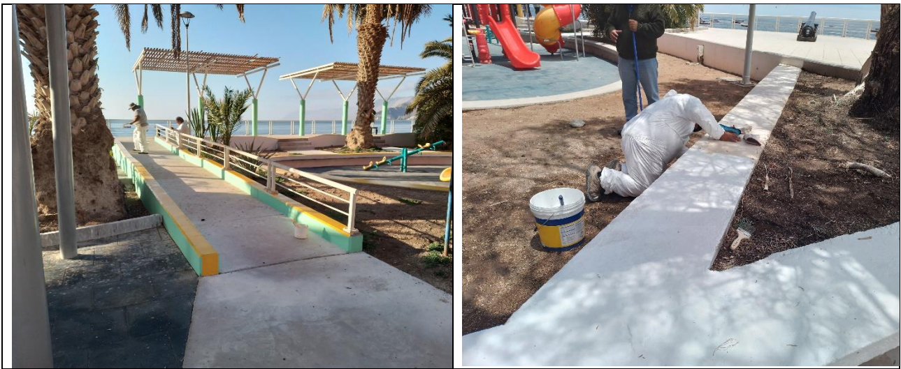
TRABAJOS DE REPARACIONES Y MEJORAMIENTO INFRAESTRUCTURA
