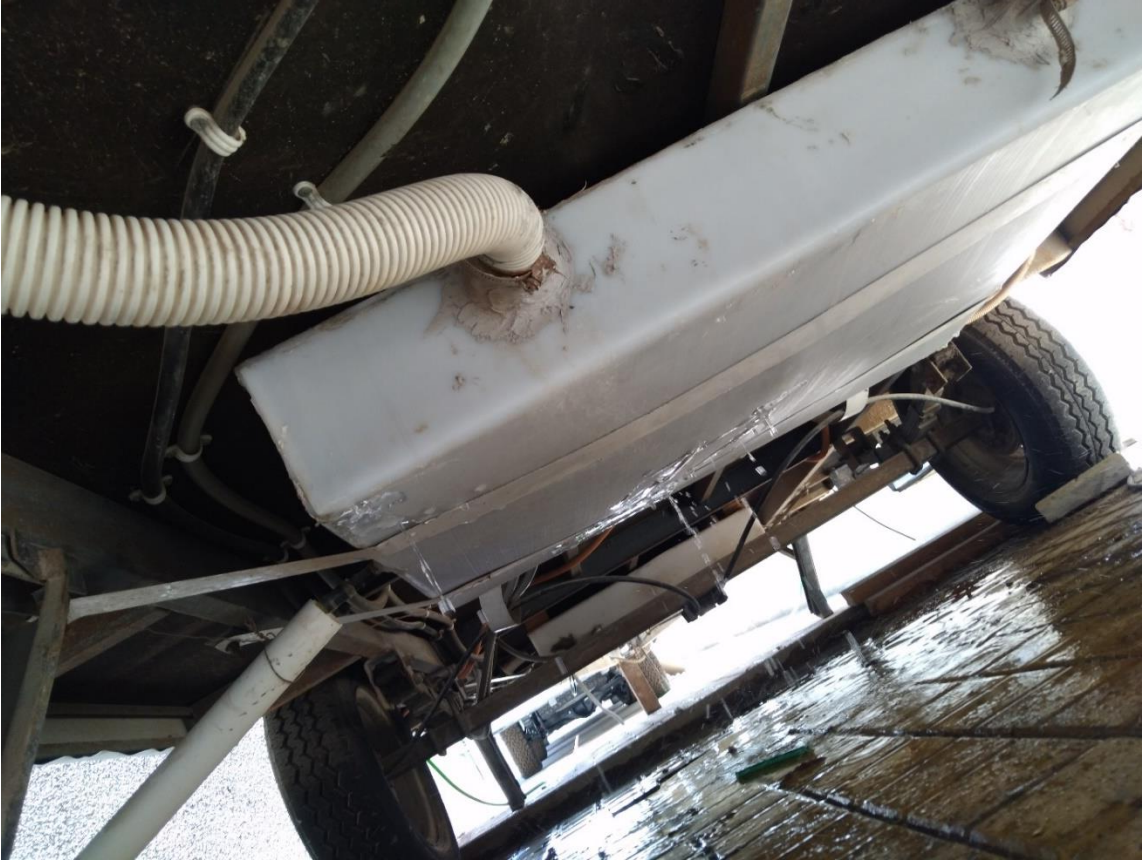
38. Apoyo en reparación de fuga de agua carro dental del cesfam Huara.
