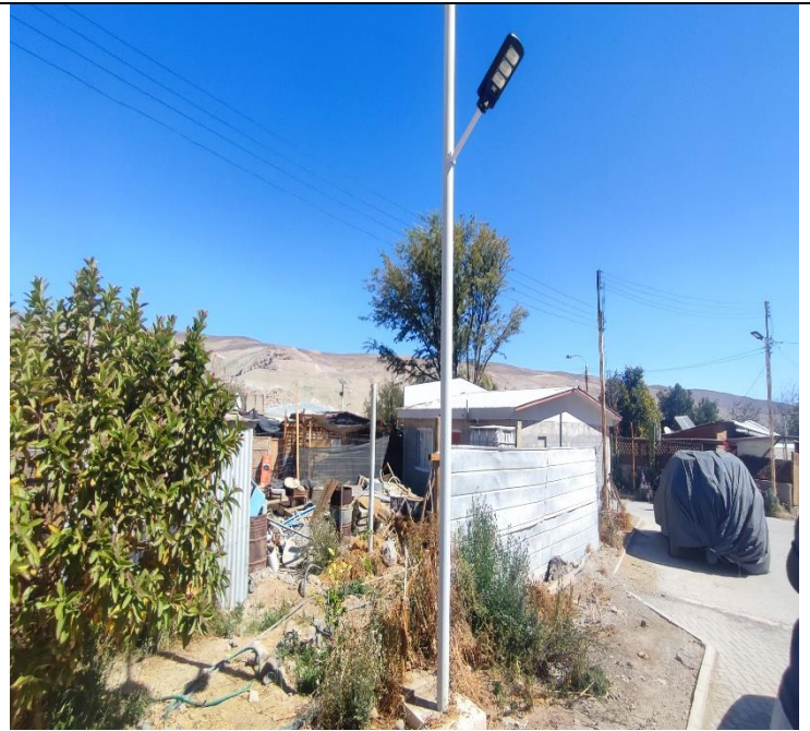
INSTALACIÓN DE LUMINARIAS SOLARES DE EMERGENCIA
